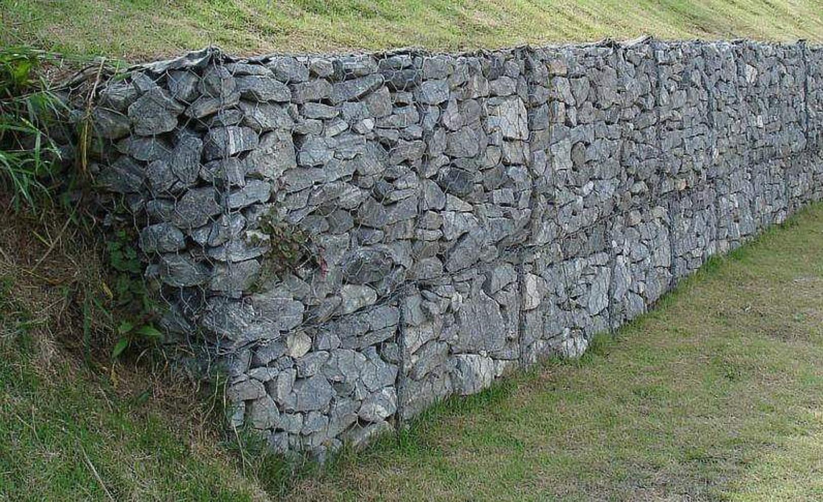
Solitamente i **GABBIONI** sono utilizzati nel campo dell'edilizia o dell'agricoltura per interventi di conservazione del suolo e contro i dissesti idrogeologici.
